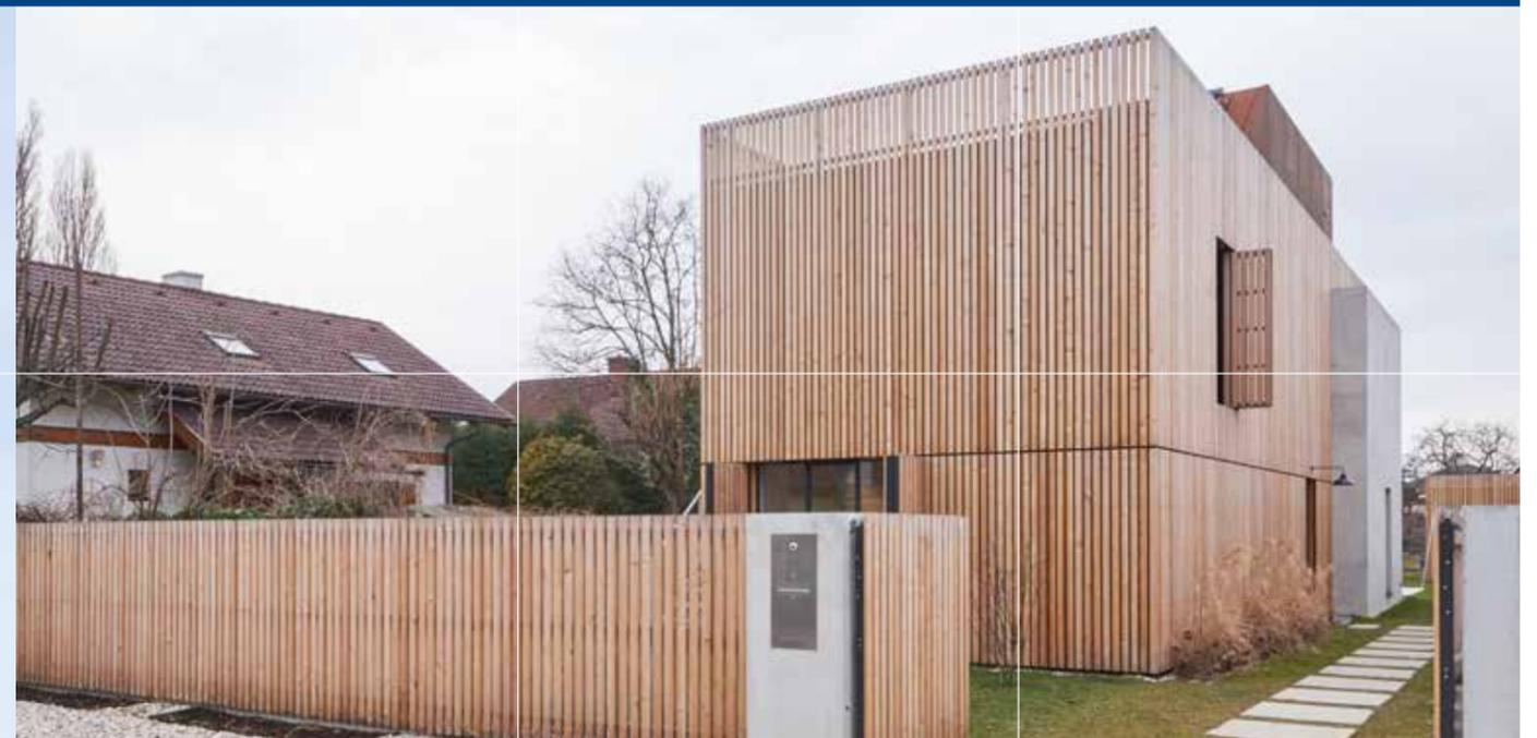
Harmonie in Material und Optik. Vorgehängte Holzfassade mit integrierten Schiebefaltläden.
