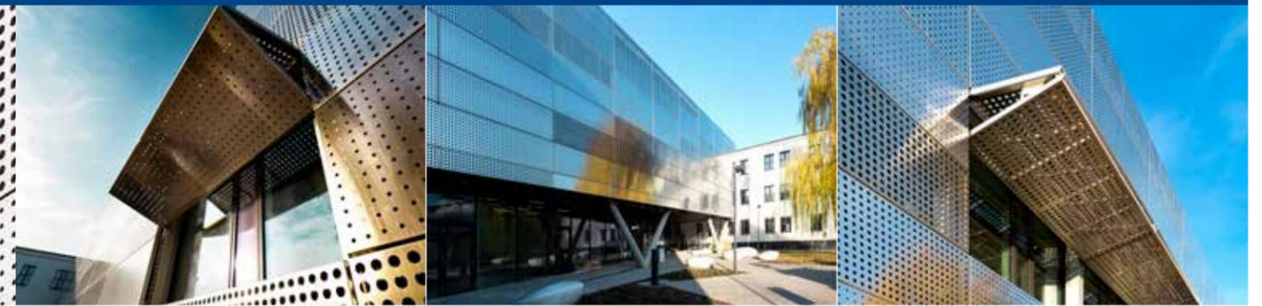
Die Fassade lässt sich auf Knopfdruck öffnen. Der Sonnenschutz „faltet“ sich nach oben.
