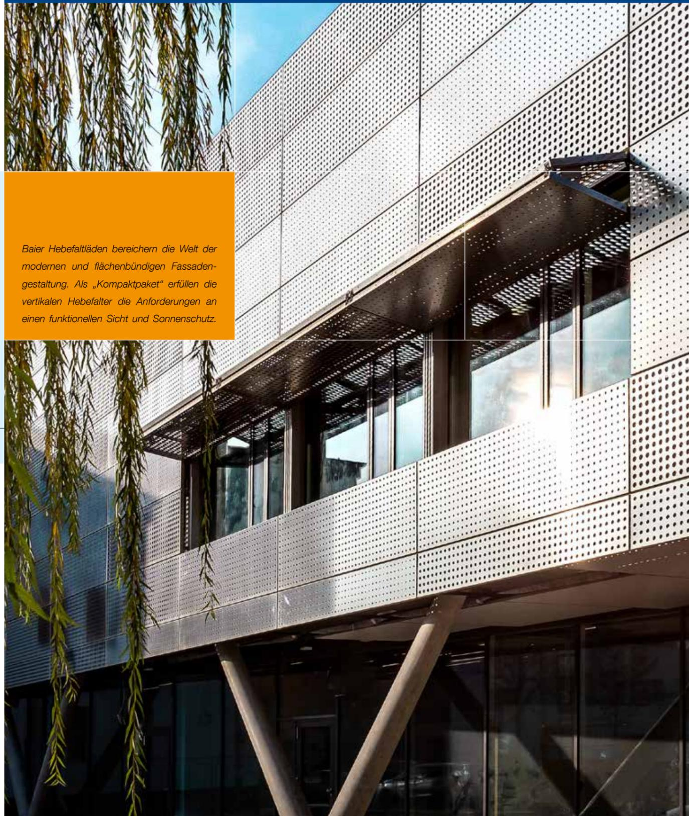
Baier Hebefaltläden bereichern die Welt der modernen und flächenbündigen Fassadengestaltung. Als „Kompaktpaket“ erfüllen die vertikalen Hebefalter die Anforderungen an einen funktionellen Sicht und Sonnenschutz.
