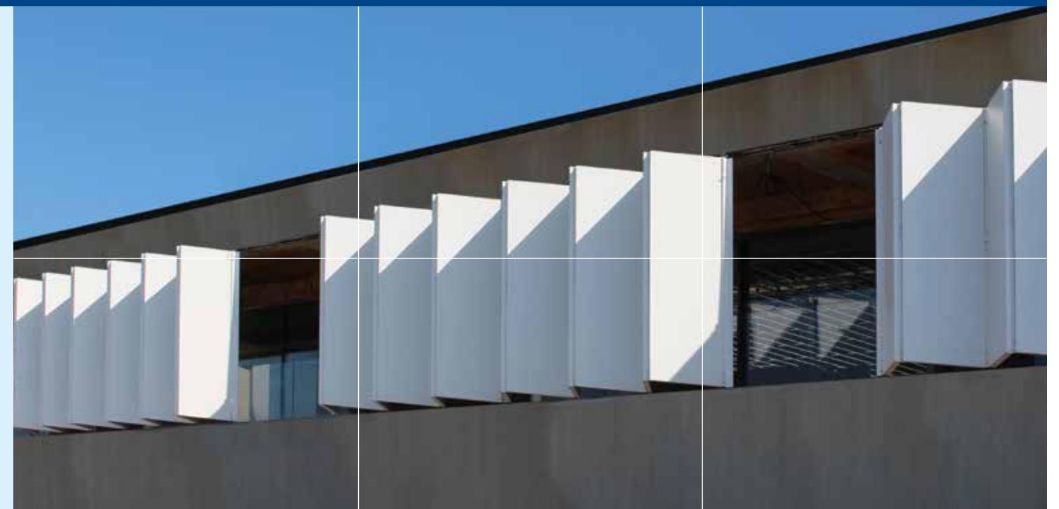
Flächige Füllung mit pulverbeschichteten Blechen wirken im geschlossenen Zustand wie eine Putzfassade.
