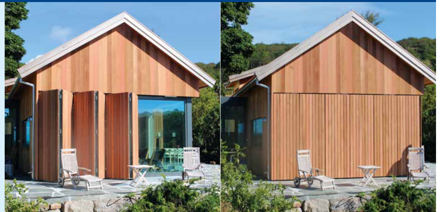
Baier Schiebefaltlagen Premium 70 eignen sich besonders dann, wenn schmalste Fugenbilder und eine homogene Fassadenverkleidung gewünscht sind.
