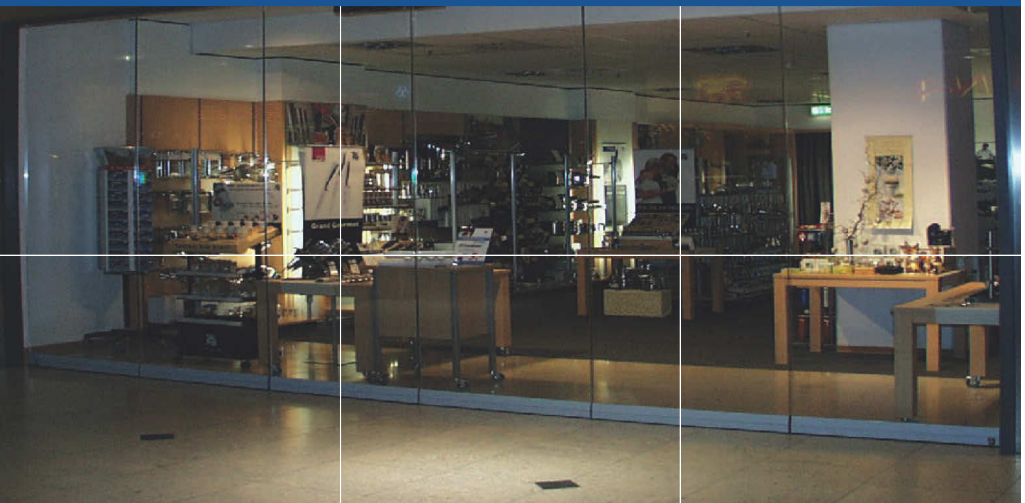
Glasschiebewände als Abtrennung von Shopbereichen im Einkaufszentrum
