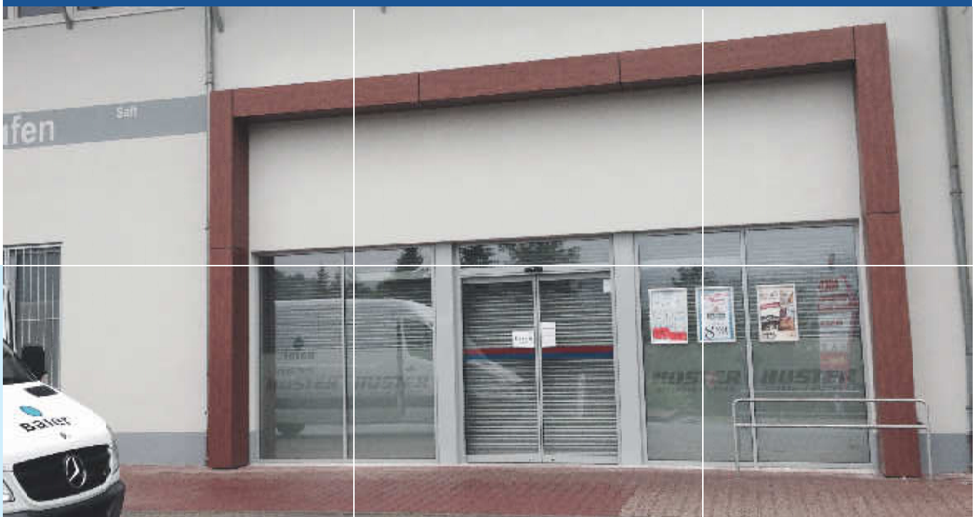
Eingangportal mit Verkleidung aus Trespa-Platten
