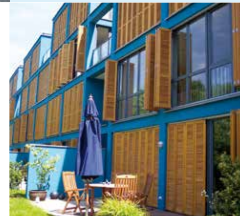
Automatische Faltläden aus Holz. Design und Funktion – hier Photovoltaik.
