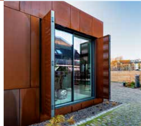
Schiebefallläden aus Cortenstahl. Denkmalgerechte Sonnenschutzlamelle.
